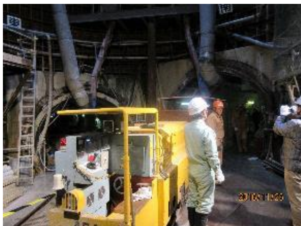
奥左右のトンネル入口が見える作業場
