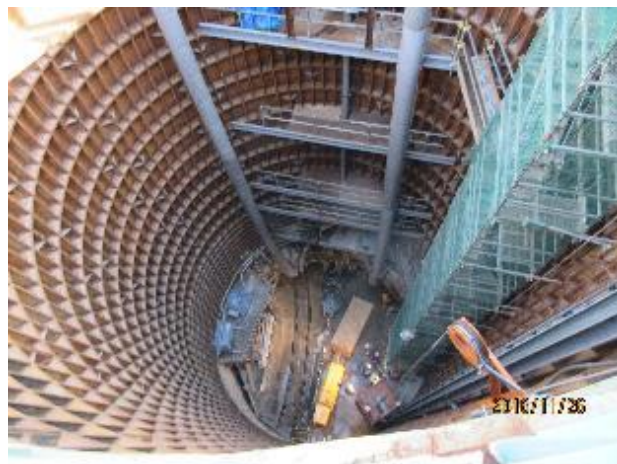
地上から撮影の 33m 地下作業場と縦穴囲
