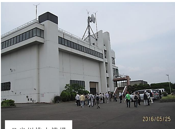
日光川排水機場
