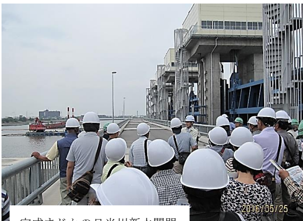
完成まじかの日光川新水閘門
